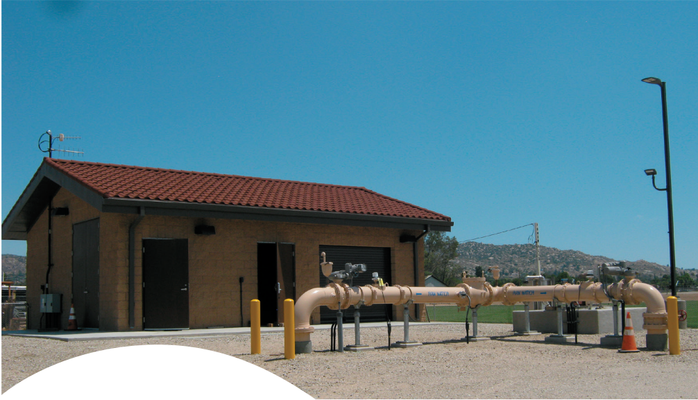
Edificio de Control del Pozo
