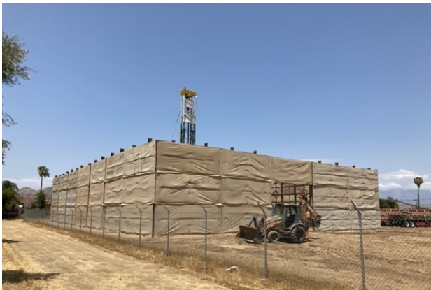
Ejemplo de un sitio de perforación con paredes de sonido.
